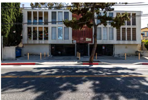
2741 S. Fremont Avenue (1963)
