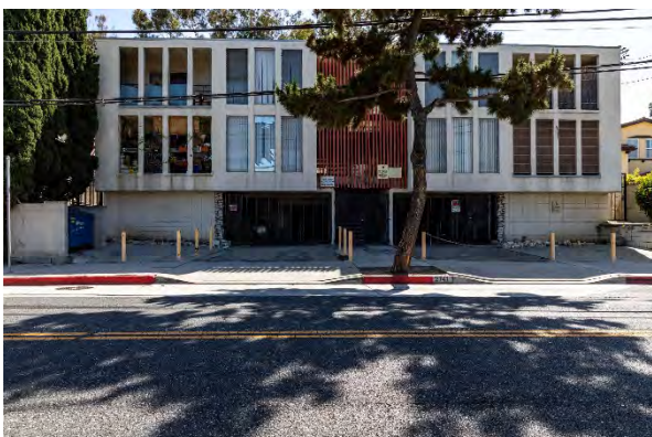
2741 S. Fremont Avenue (1963)
